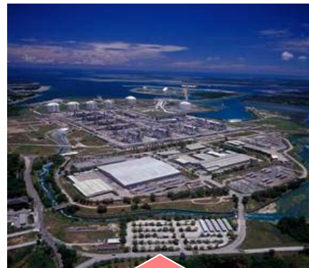
(Bontang LNG Plant)
